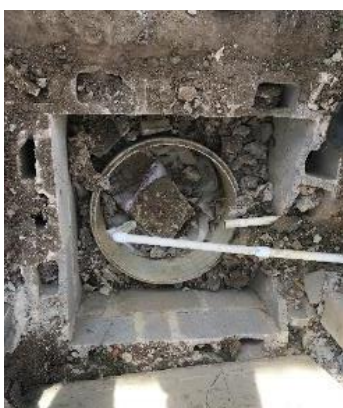
Foto No.1 Pozo profundo sellado
