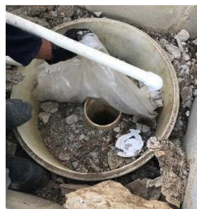
Foto No.2 Pozo profundo sellado
